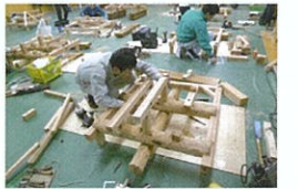
▶大工育成講習で行われた、丸太小屋組の実技の様子。
